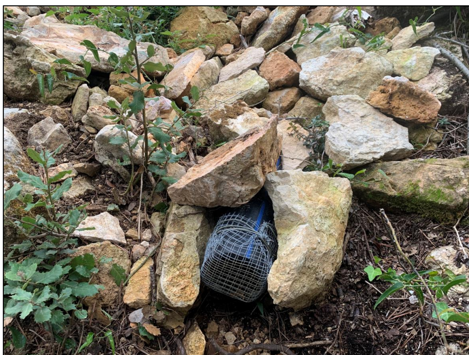
Figure 5 : Exutoire de la purge du forage
